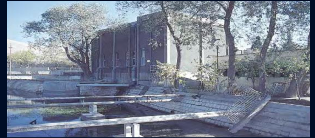
Водопровод и насосная станция в Таслудже (1982-1983)
