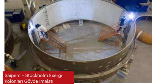
Saipem - Stockholm Exergi Absorber Kolonu Bombe İmalatı
