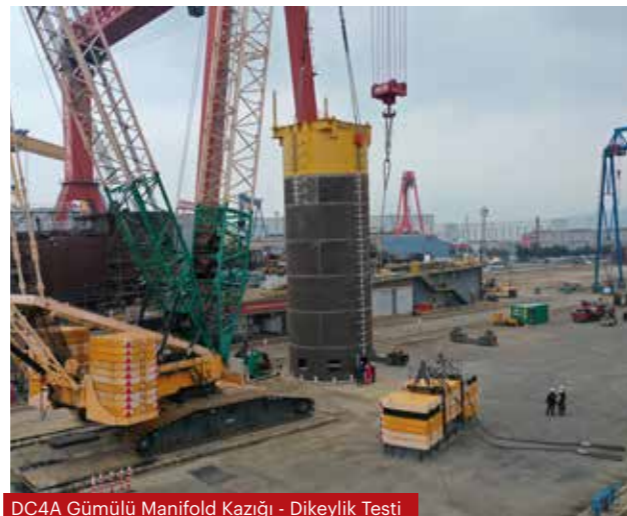
DC4A Gömülü Manifold Kazığı - Dikeylik Testi
