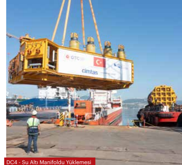
DC4 - Su Altı Manifoldu Yüklemesi
