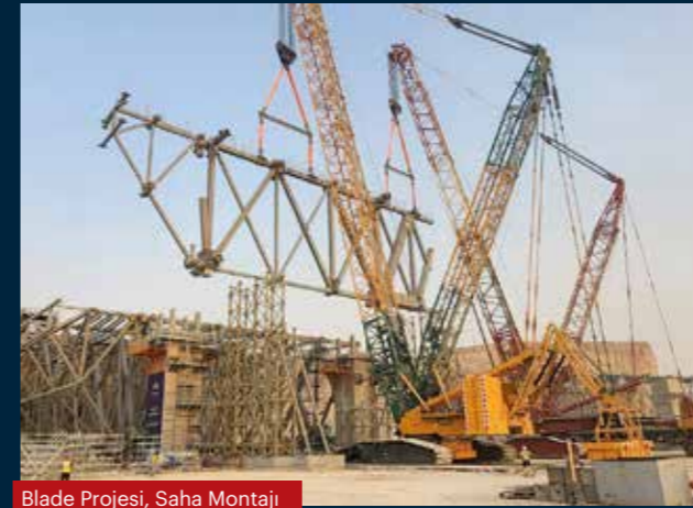
Blade Projesi, Saha Montajı
